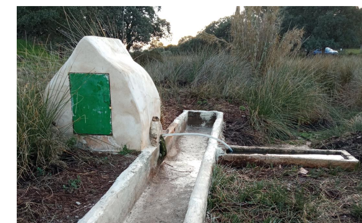
Fuente y abrevadero restaurados.
